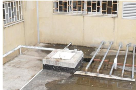
شكل (26): تسرب المياه بجانب خزان أرضي
