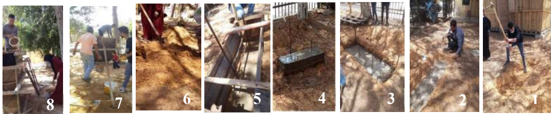
الشكل (9): التطبيق العملي لحائط التربة المدموكة
