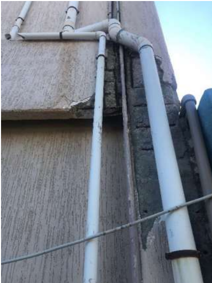
شكل (15): سقوط الغطاء الخرساني للسقف بالدور الثالث نتيجة صدأ حديد التسليح
