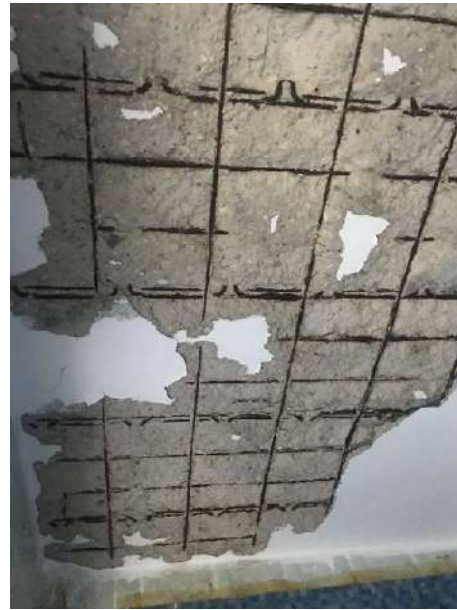
شكل (7): سمك الغطاء الخرساني اقل من 1سم في الاسقف
