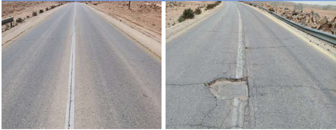
(ج). الشقوق العرضية مع شقوق الكلال والحفر د. شقوق طولية وعرضية بتباعد 3 متر متباعدة
