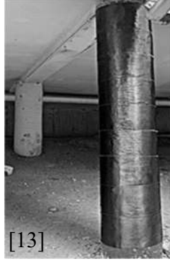
شكل رقم (6): تقوية الأعمدة الخرسانية بألياف الكربون
