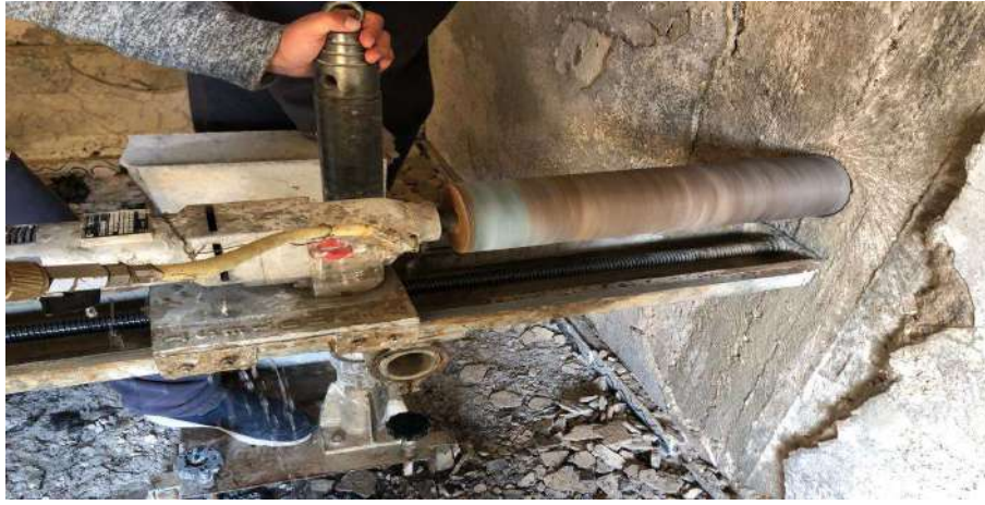
الشكل (6): عينة لب خرساني من عمود
