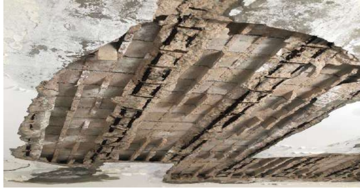
الشكل (8): تساقط خرسانة البلاطات
