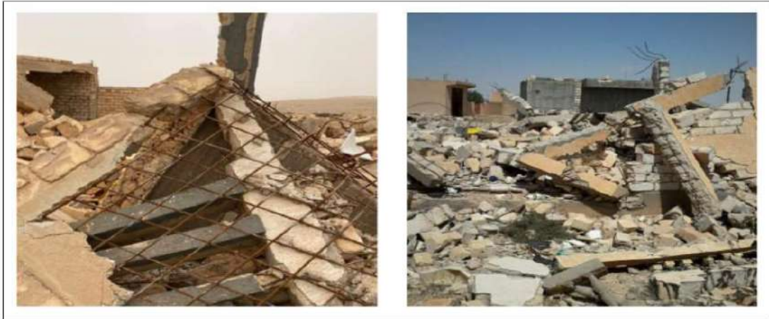
شكل 3-4 هدم المباني والمخلفات الناتجة عنها
