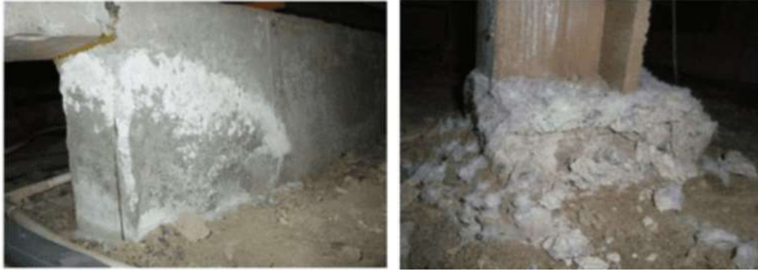
شكل (2): هجوم الكبريتات الفيزيائي على الخرسانة (ظاهرة التزهير) [14]
