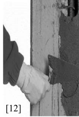
شكل رقم (5): طريقة حشو العمود الخرساني الايبوكسي
