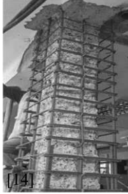
شكل رقم (7): تدعيم الأعمدة الخرسانية بالقمصان الحديدية
