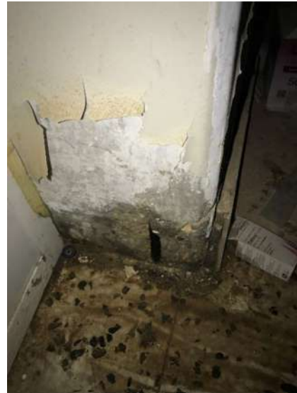
شكل (14): تآكل حديد التسليح وانفصال الغطاء الخرساني (الذي يقل عن 1 سم)
