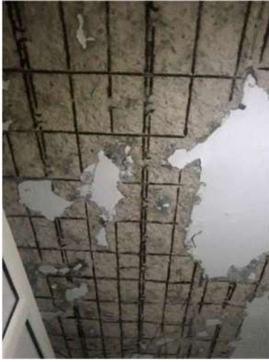
شكل (13): سقوط الغطاء الخرساني للسقف بالدور الثالث نتيجة صدأ حديد التسليح
