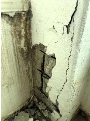
شكل (11): انتشار لتآكل حديد التسليح لنفس العمود للدور الثالث
