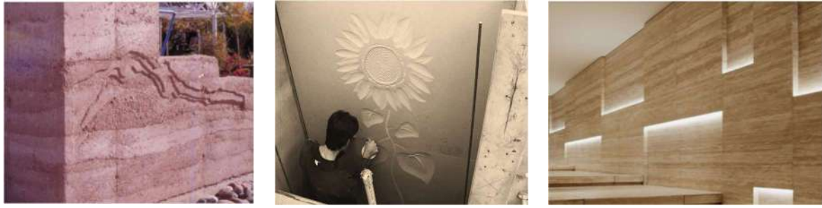
الشكل (4) شكل التشطيبات على حائط التربة المدموكة [11]
