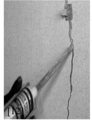
شكل رقم (4): طريقة حقن الشقوق بالأعمدة الخرسانية
