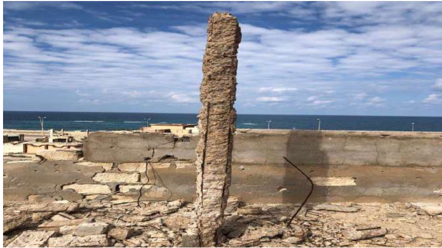
الشكل (2): تدهور الخرسانة وصدأ حديد التسليح
