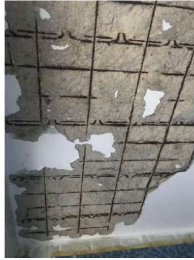
شكل (12): تآكل حديد التسليح وسقوط الغطاء الخرساني للسقف بالدور الثاني
