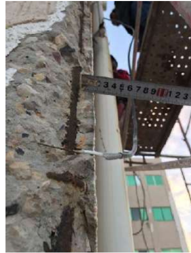
شكل (10): تآكل حديد التسليح لعمود في الدور الأرضي مع غطاء خرساني يصل الى 1.5سم للحديد الرئيسي وللكانات اقل من 1 سم
