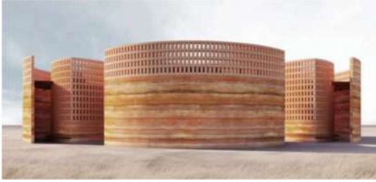
الشكل (1): شكل الحوائط المدموكة [12]
